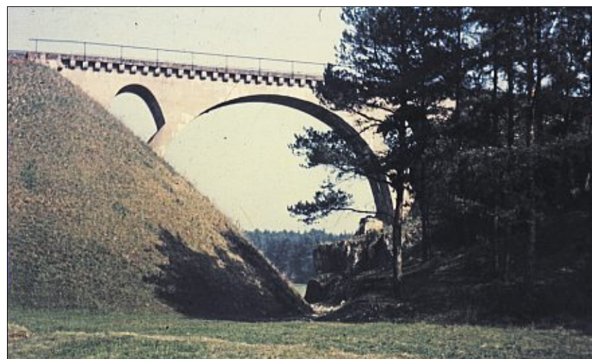
1962 war das Haager Viadukt ein Beispiel für noch nicht verwachsene Jura-Hänge. Bilder: Brü (2)
